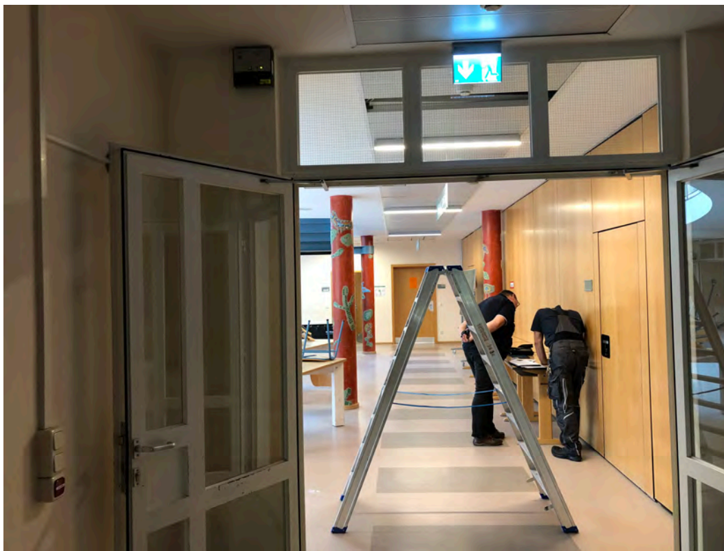
Pos. 02..__0010 Demontage/Abbruch/Entsorgung Bestandselement, Stahl/Glas-Türe 2-flg. mit OL Abmessungen ca. 2015 x 2800 cm
